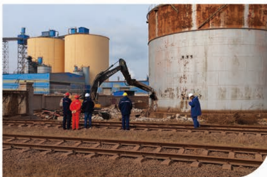
油库拆除工程现场
