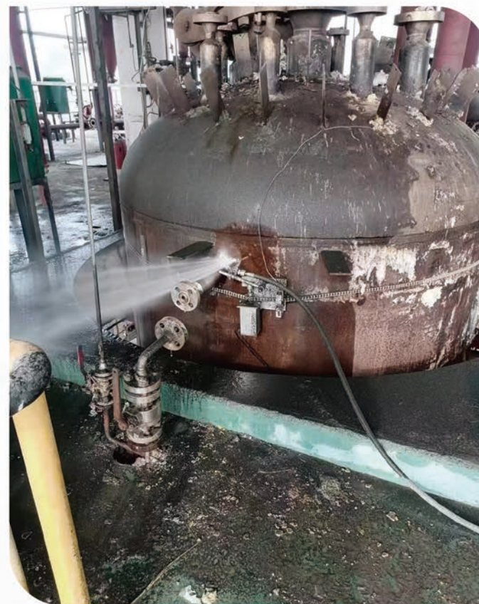
不动火水切割现场
