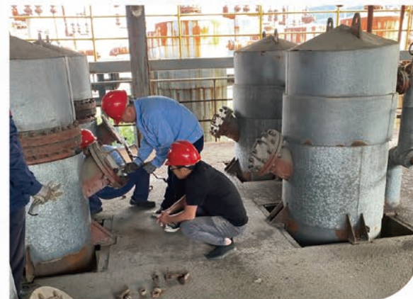
精密工序过滤器拆除人孔
