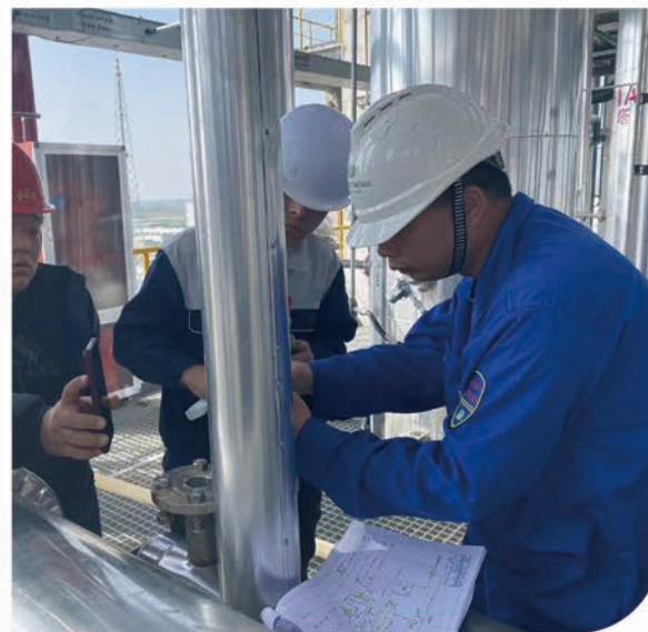
管道清洗钝化现场
