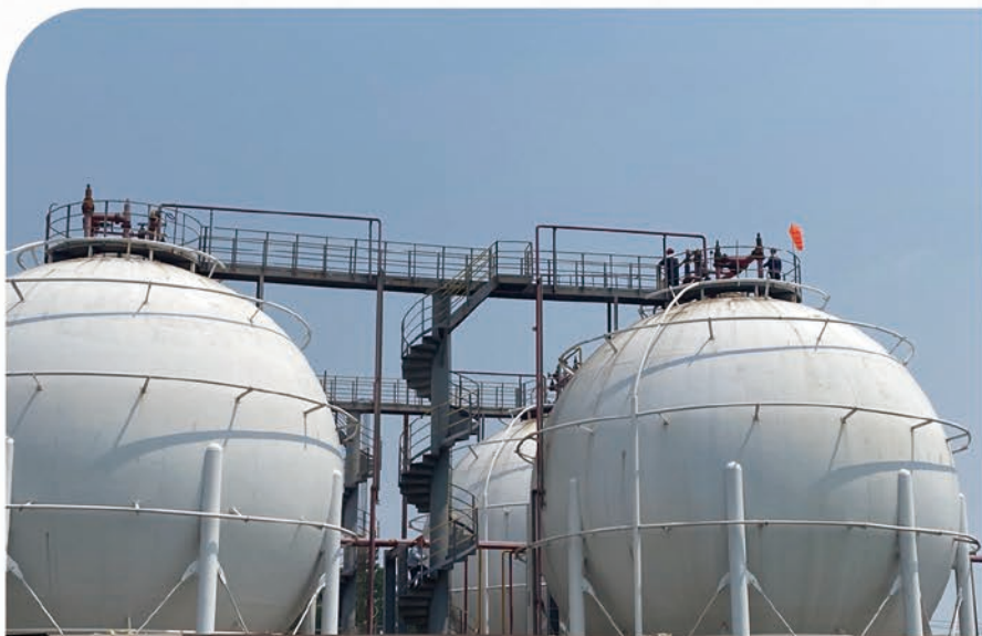
丙烯球罐拆除现场
