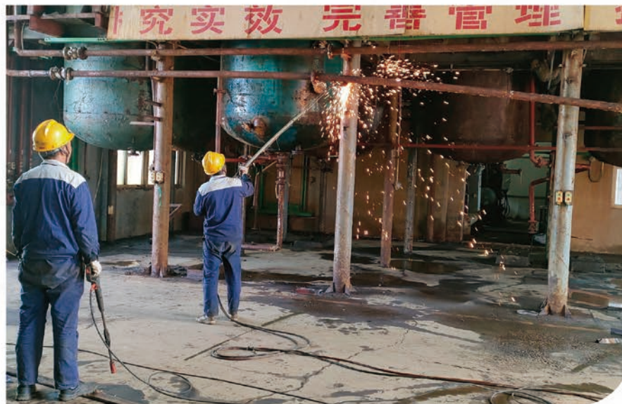
成品车间动火拆除现场
