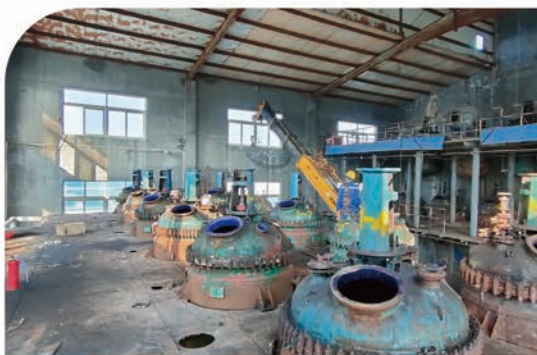
反应釜化学物料置换拆除现场
