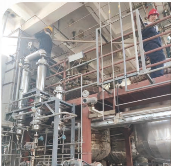
化工装置拆除前清洗现场
