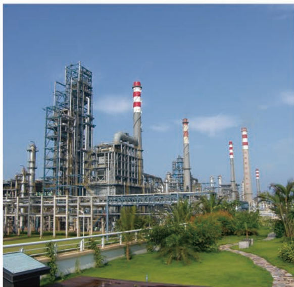
煤化工厂开车前清洗现场
