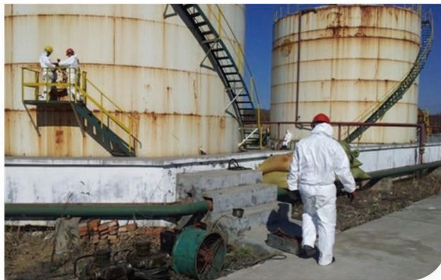
大型油罐清洗现场
